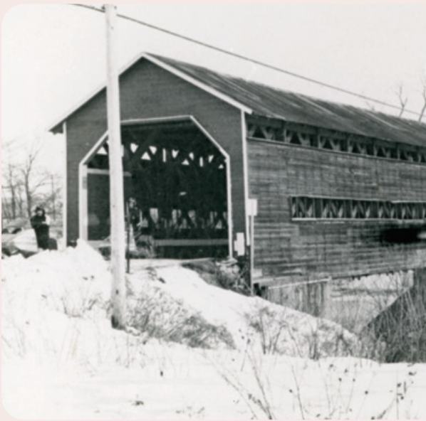
Le pont, d'une longueur de 56,40 m (185 pi) et d'une hauteur de 3,70 m (12 pi), possédait deux travées.
