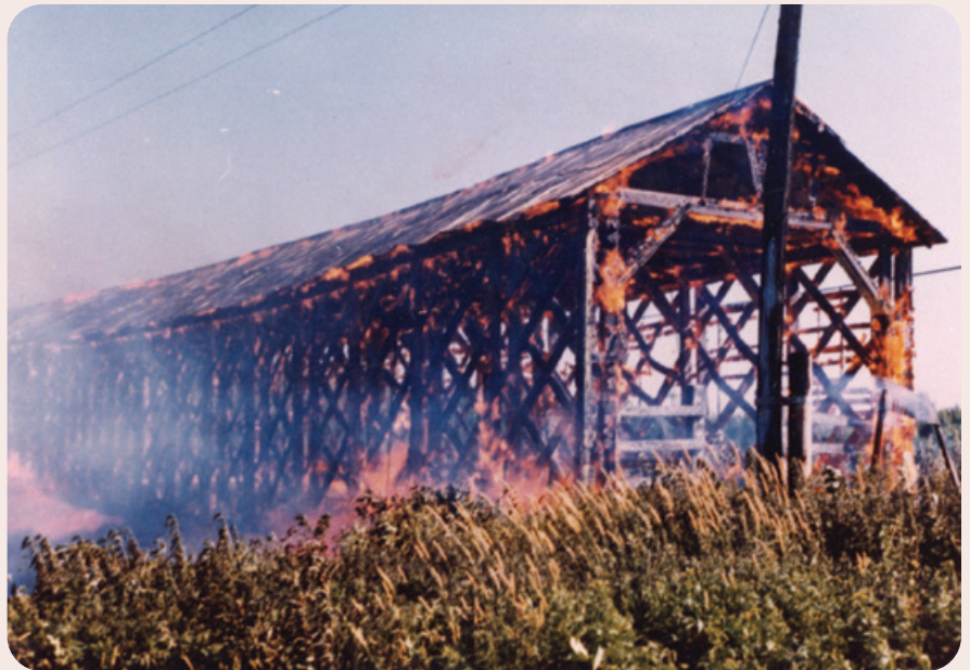
Le 31 juillet 1974, un incendie de nature inconnue embrase complètement le pont. Après avoir résisté aux intempéries et aux crues printanières pendant 37 ans, ce sont les flammes qui auront eu raison de sa structure.
